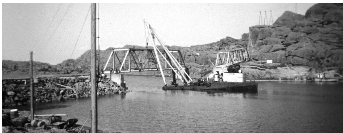
Brua over Indre Steinsund under bygging. Bruarbeidet starta 1. mars 1963, og støypearbeidet var ferdig 1. november. Firmaet Lau-Eide frå Bergen utførte arbeidet, og ein del av arbeidarane kom frå Solund. Foto: Ola Steinsund
